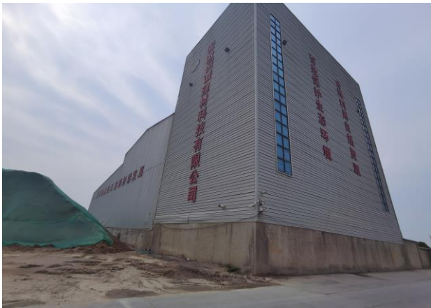
图 3-3 废气处理设施（封闭式厂房）
